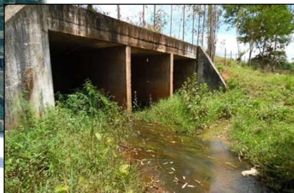
Imagem de montante do ponto HercS-HA-12 (Ponte).
